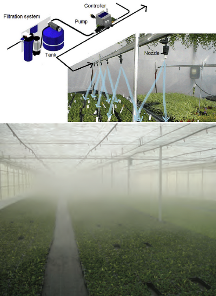
ภาพที่ 4 การพ่นละอองน้ำในโรงเรือนโดยใช้ปั๊มน้ำแรงดันสูงและหัวพ่นละอองน้ำโดยเฉพาะเหนือทรงพุ่มพืชปลูก
